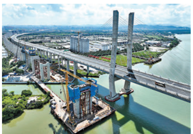
◆9月1日,深江鐵路關鍵性工程跨磨刀門水道主橋東主墩下橫樑澆築完成。該橋橫跨中山和江門兩市交界的西江磨刀門水道,主橋為140米高墩大跨斜拉橋。 新華社
