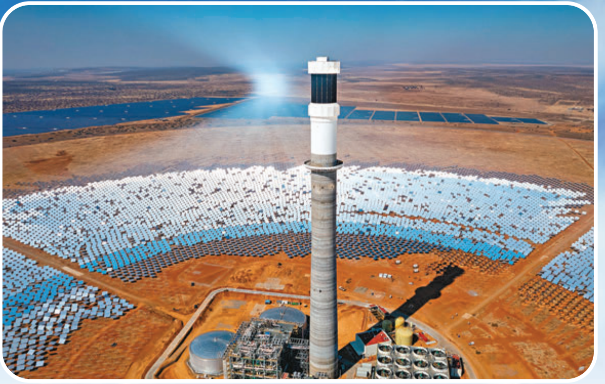
由中國企業承建的紅石項目近期併網發電，預計為20多萬戶家庭提供穩定的電力供應。圖為南非紅石100兆瓦塔式熔鹽光熱電站項目。
