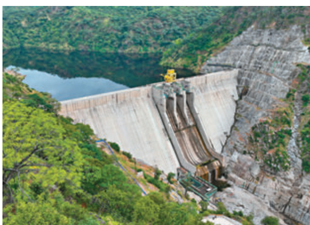
▲2023年3月，中企承建的贊比亞下凱富峽水電站5號機組開始發電。資料圖片
