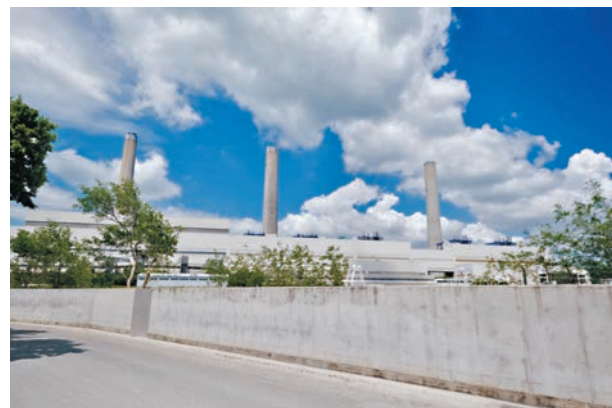
●南丫發電廠在多個關鍵地點設置約兩米高防洪牆。 香港文匯報記者涂穴 攝
