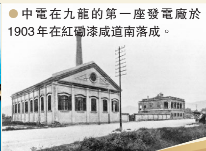
●中電在九龍的第一座發電廠於1903年在紅磡漆咸道南落成。
