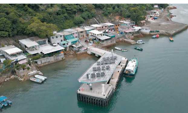
●重建後的新瀝西村碼頭改善了泊位水深。發展局圖片
