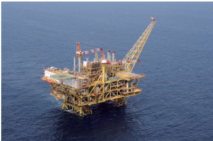
■荔灣天然氣項目的中心設施平台。
