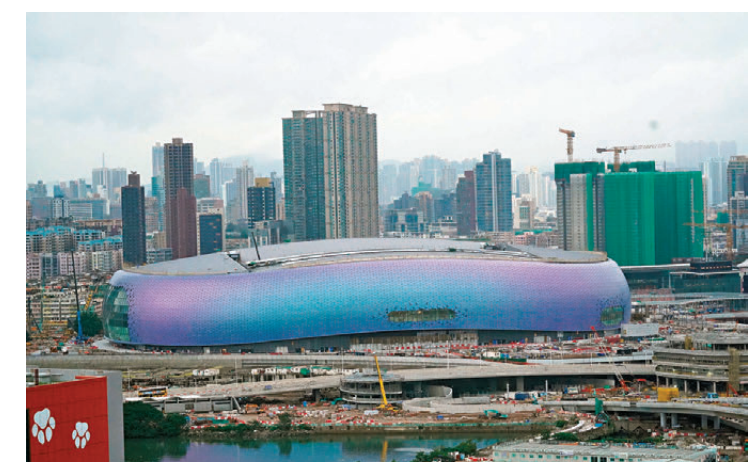
●啟德體育園8月及9月發生3宗漏水個案，均為喉管測試時發生。資料圖片
