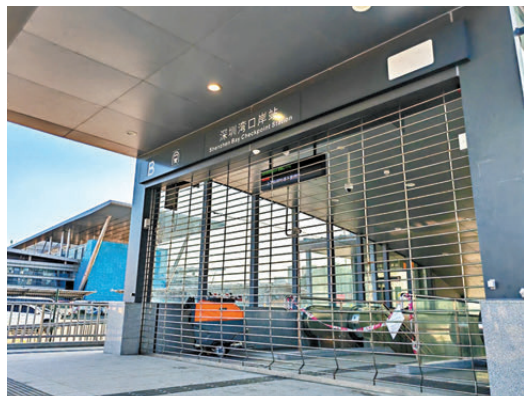
地鐵13號線深圳灣口岸地鐵口。
