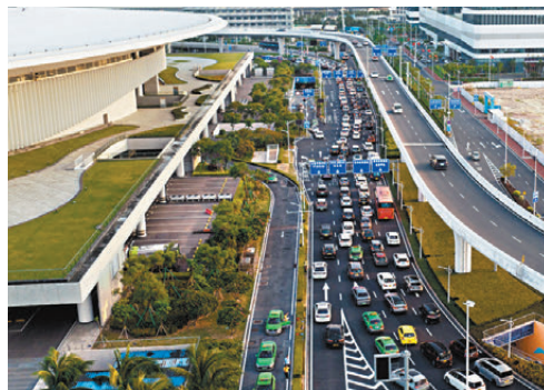
●港澳車輛經過港珠澳大橋珠海口岸。香港文匯報珠海傳真
