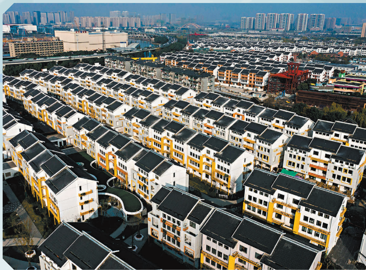
● 住建部將通過貨幣化安置等方式，新增實施100萬套城中村和危舊房改造。圖為浙江杭州城中村改造升級打造的新型城市「未來社區」瓜山新苑。 資料圖片
