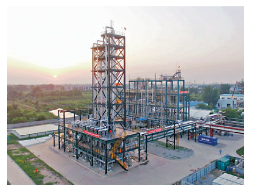
●中國科學院大連化學物理研究所通過先進的「生物質催化轉化製乙二醇」技術，生產出乙二醇產品。圖為千噸級生物質催化轉化製乙二醇裝置。 受訪者供圖
