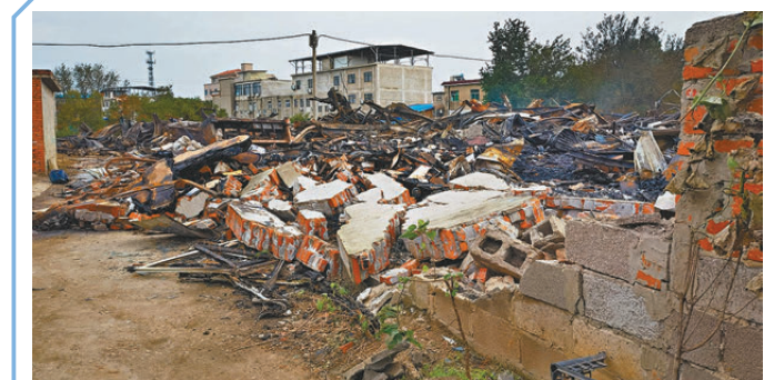
●10月19日5時許,安徽省淮南市潘集區架河鎮王圩村一自建房發生火災。圖為火災事故現場。中新社
