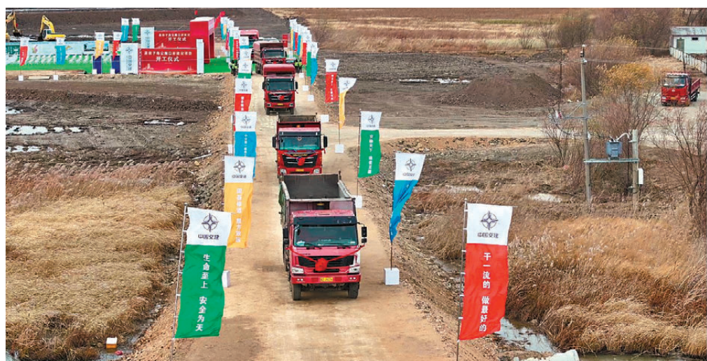
●黑瞎子島公路口岸建設項目日前正式開工，標誌着黑瞎子島中俄國際合作示範區建設跨入歷史新階段。受訪者供圖
