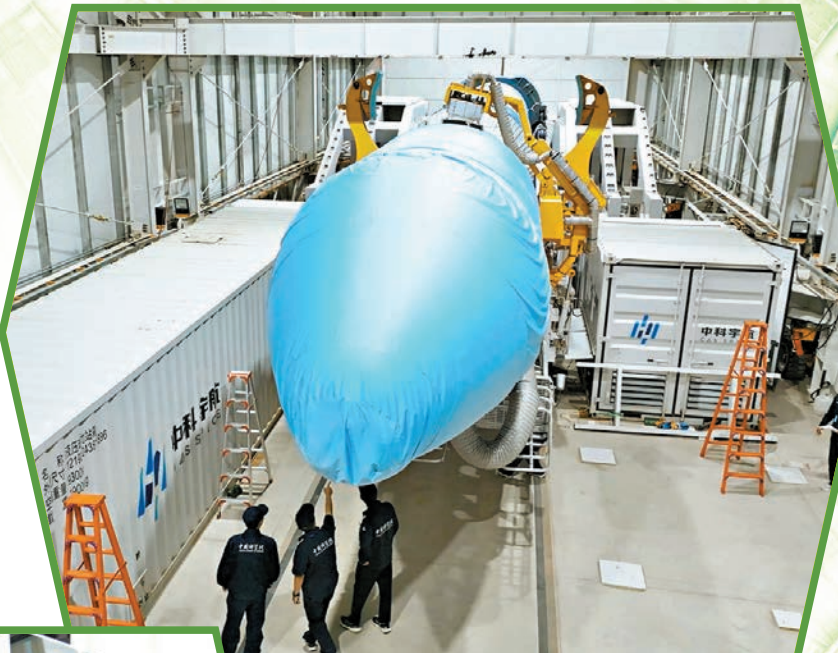
●中科宇航(廣州)希望立足於大灣區，布局航天產業鏈上下游。圖為中科宇航「力箭一號」火箭在發射塔安裝調試。 香港文匯報廣州傳真
