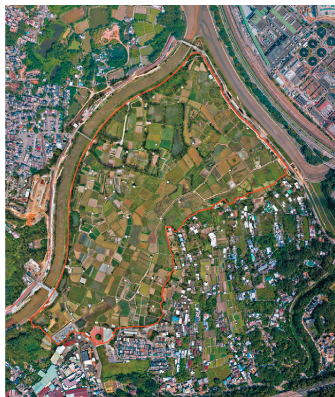
●望原自然生態公園佔地大約37公頃，紅色為公園範圍。
