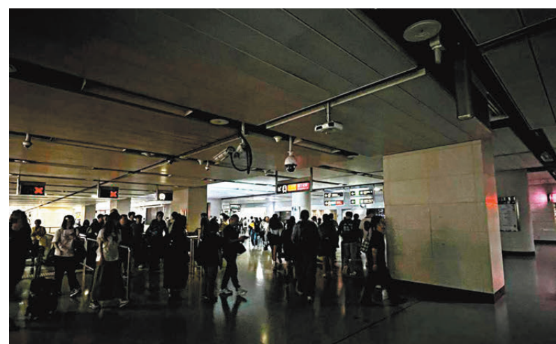
●上周五(15日)晚上11時許，香港站東涌線大堂一度出現電力故障。 資料圖片
