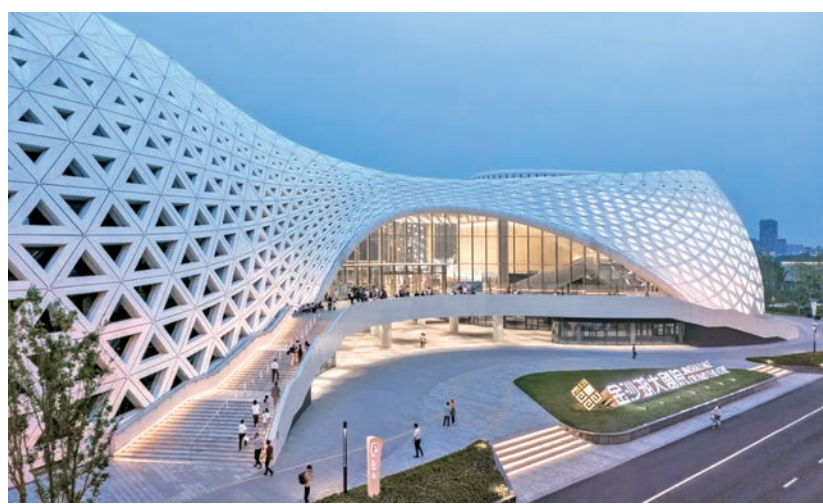
圖註：金沙湖大劇院高效能源項目。
