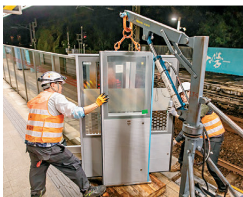
●大學站的自動月台閘門工程已於日前展開。港鐵圖片
