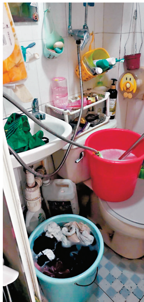
●劏房廁所空間狹小，積水甚多。
