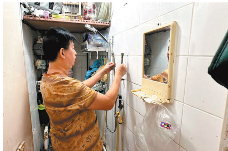
●昨日所見，單位內的熱水爐已經被拆走。
