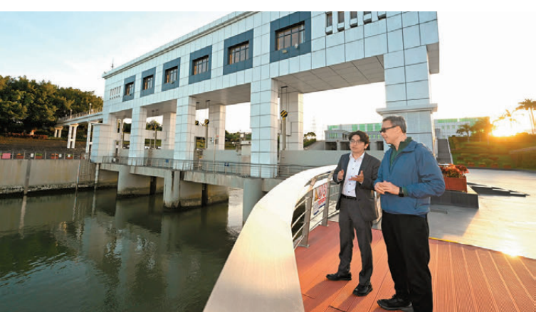
●水諮會委員林日豐（右）和水務署署長黃恩諾（左）昨日參觀東莞市太園泵站輸港東江水取水口。
