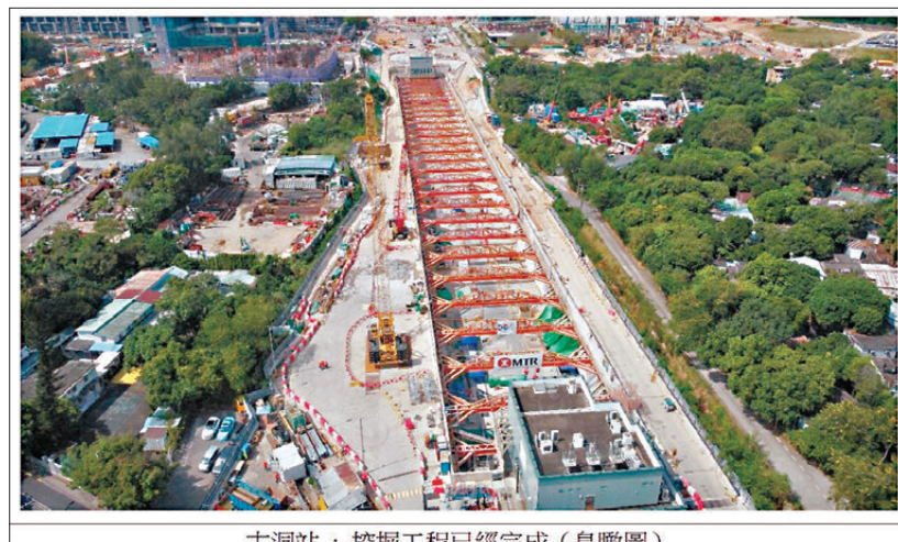
古洞站：挖掘工程已經完成（鳥瞰圖）
