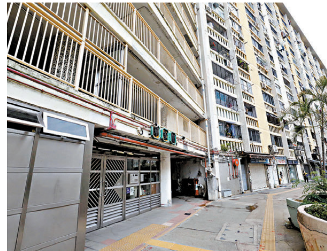
●華富站選址於該邨華安樓與華樂樓之間的華富道地底，該站將會採用島式月台設計。圖為華安樓。資料圖片
