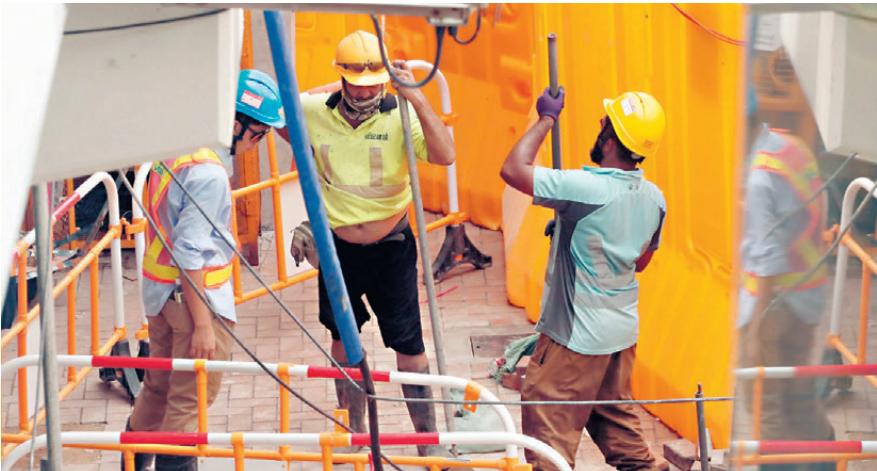
●香港建造商會表示，仍有工人被拖糧，很可能是二判、三判因自身資金不足，才沒有向工人發薪金。圖為工人烈日下在地盤工作。
