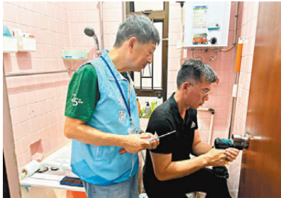
●維園關愛隊隊員協助長者浴室安裝防滑扶手。
