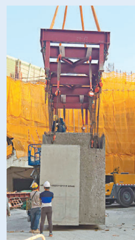
「組裝合成」MiC建築法，可提升建造業的生產力和成本效益。
