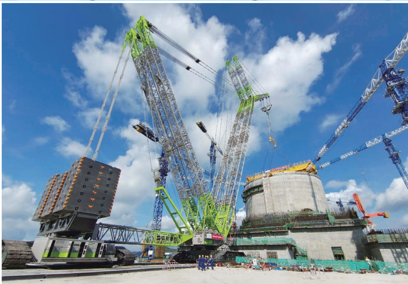
●中聯重科ZCC3200NP進行漳州核電「華龍一號」1號機組吊裝。
