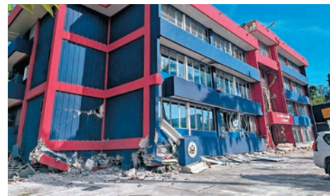
所建築內，該建築在地震中遭受嚴重破壞。社交媒體上流傳影片顯示，維拉港主要街道上的一幢建築部分倒塌，並壓壞多架車輛。有目擊者稱，維拉港附近發生嚴重山泥傾瀉。
