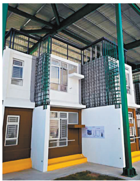
▲何永賢到珠海視察簡約公屋啟德項目「組裝合成」組件生產。何永賢Fb圖片
