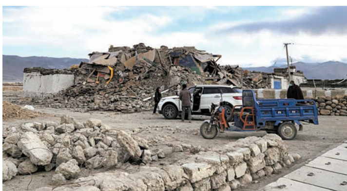
●定日縣災區房屋坍塌嚴重，部分民房幾乎被夷為平地。 受訪者供圖
