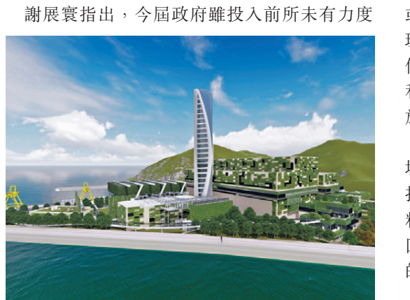
●香港正在建設首座處理都市固體廢物的轉廢為能設施(I-PARK1)。
