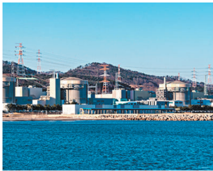
●韓國月城核電站二號機組非正常排放29噸核廢液。網上圖片
