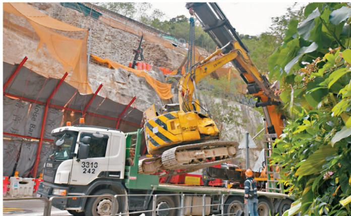
●藍田連德道斜坡工程昨晨發生嚴重工業意外，一部挖泥機疑失平衡滾下斜坡，意外不排除工程因泥土鬆軟致挖泥機滾下，或涉地盤安全管理問題。
