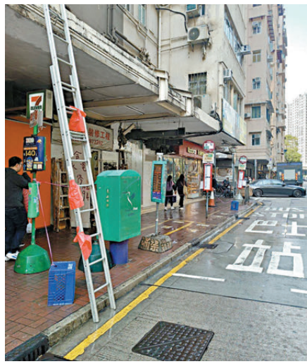
●文英樓糞水倒灌由簷篷流落地面，行人路上的巴士及小巴暫時被圍封，防止行人接近。區議員供圖
