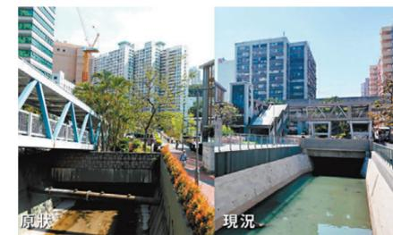
●提升防洪能力是活化翠屏河工程的重要目標。工程團隊優先改建翠屏道行人天橋，再移除舊有天橋基座，消除排洪障礙。網誌圖片
