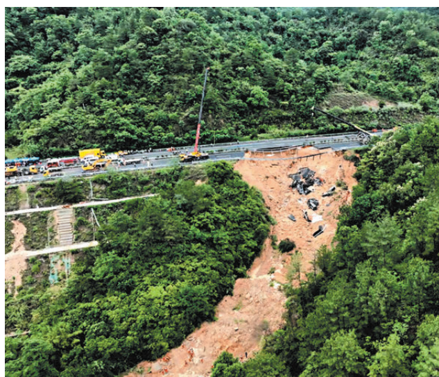
●2024年5月廣東梅大高速路面塌方事故現場。 資料圖片
