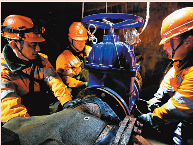
●濟西水電工區管道工的搶修工作經常是夜間在井下完成。
