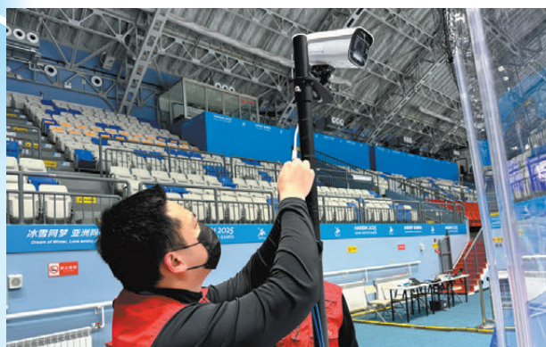
●工作人員在場館安裝智能畫面採集設備。香港文匯報哈爾濱傳真
