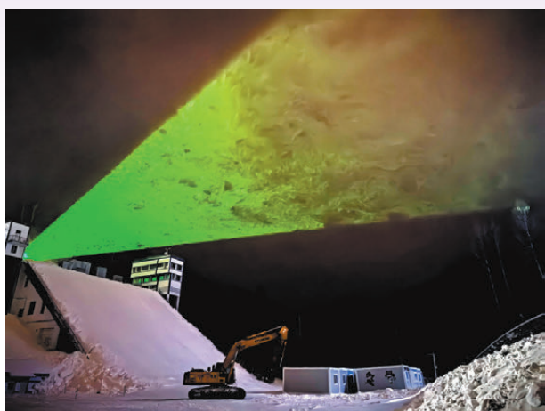
●妙用「冰雪魔法」讓寒風顯形，成功解析了空中技巧項目跳台上方關鍵區域的複雜流場特徵。
