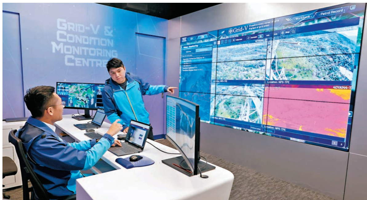
●為應對極端天氣頻發及保障供電穩定，中華電力與本地網絡運營商合作研發智能管理系統Grid-V，並在去年9月首次應用於中電電網。
