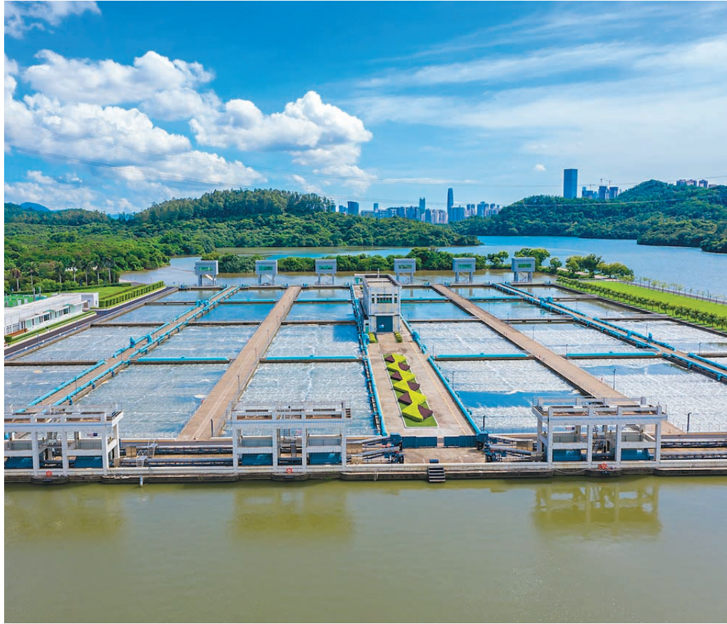
●東江水在深圳水庫的生物硝化站過濾、淨化後送往香港。
