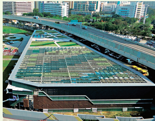
● 現時使用中的啟德發展區區域供冷系統（北廠）。謝展寰網誌圖片
