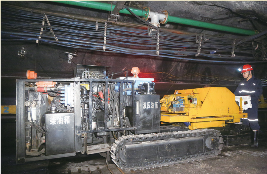
●中煤華晉公司王家嶺礦井下，工作人員操作內地首台托輾機器人在不停機的情況下進行托輾更換。
