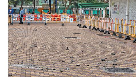
●瑞泰樓高層外牆大片紙皮石連石屎剝落，飛墜對開路面。
