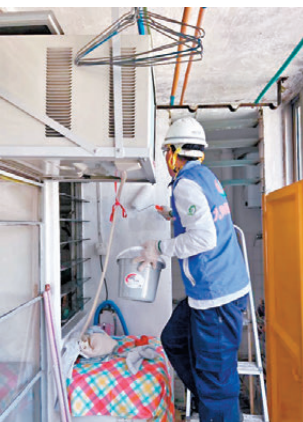
●關愛隊為區內長者住戶修補家中剝落的牆身油漆。作者供圖
