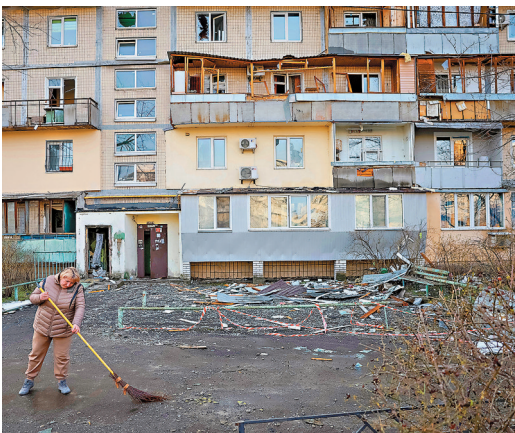
●烏克蘭基輔一棟大樓遭俄無人機襲擊，一名居民正在清理現場。路透社
