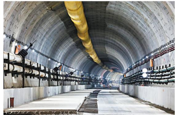
●汕頭灣海底隧道盾構貫通段。汕頭灣海底隧道全長9,781米。
