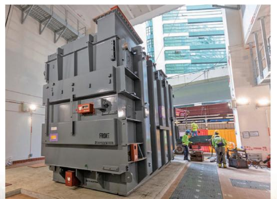
●中電與嘉民團隊解決項目鄰近架空天橋的限制，將高壓及重型電力設備設於地面樓層。
