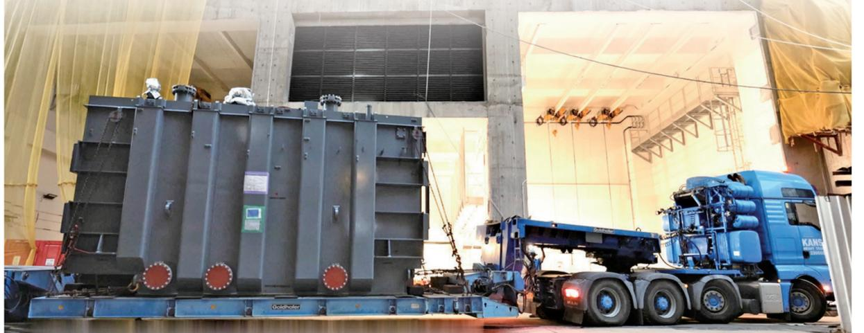
●一組大型電力裝置組件重達70噸，在工程設計上需騰出空間，方便運送設備。
