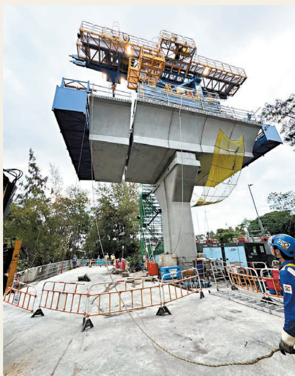
●中國路橋香港公司位於落馬洲的橋樑項目施工，實現橋樑節段整體吊裝，減少對既有交通的干擾。 受訪者供圖
