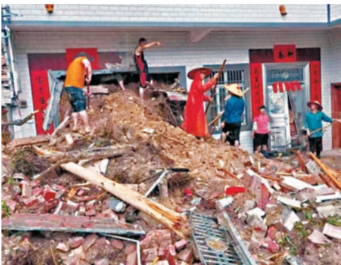
●茂名一座房屋倒塌嚴重，現場堆滿泥沙、防護網、防盜鐵門等雜物，搜救人員在不停搜救。視頻截圖
