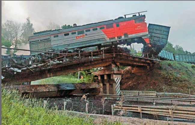
●庫爾斯克州一座鐵路橋樑被炸毀，一列貨運列車部分車廂墜落公路。 美聯社
