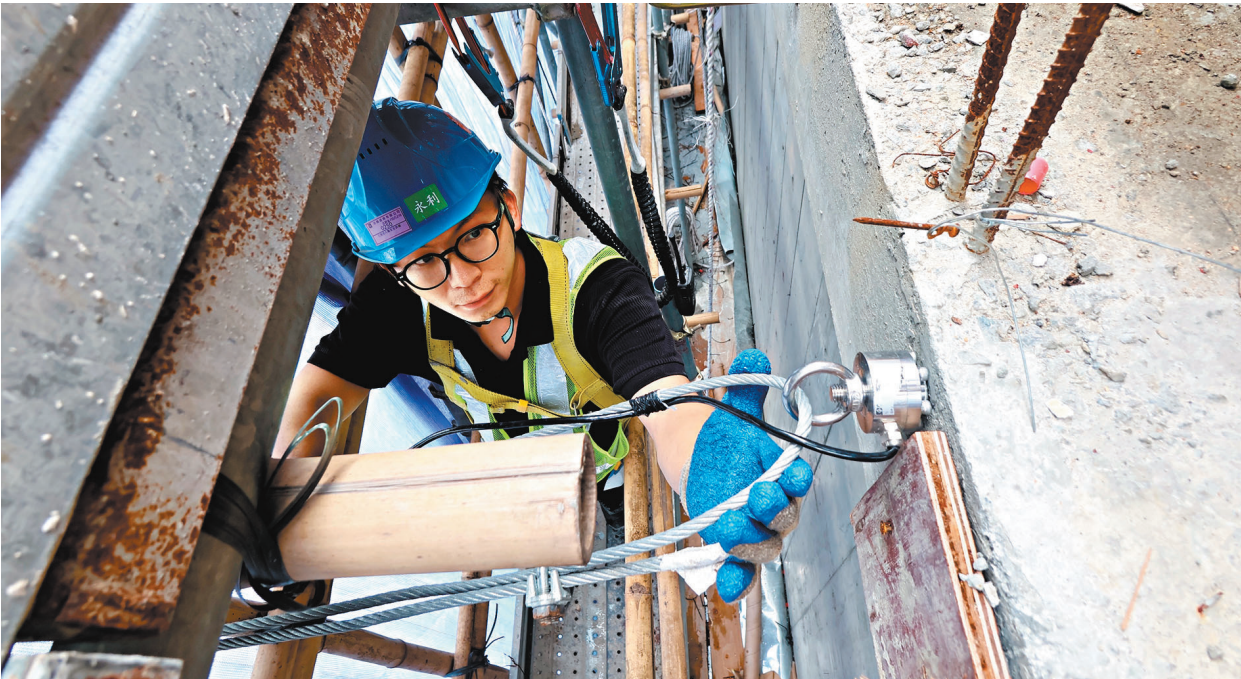
●新輝建築表示，TIE.AI智能棚架監測系統現已在古洞一個地盤試用，未來將提供20個名額，讓小型建造商免費體驗，推動業界廣泛應用。
