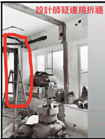
▲裝修工程鑿穿客廳與睡房之間的一幅牆壁，擬改成主人房的房門。資料圖片
